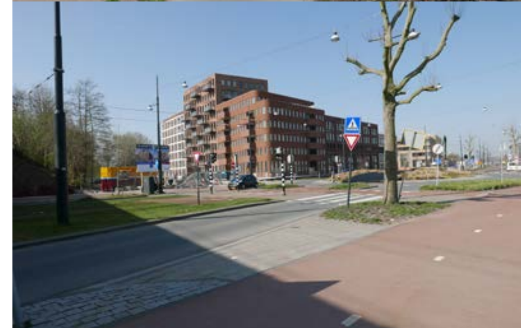
Foto's huidige situatie deelgebieden E2, het spoorviaduct over de Muiderstraatweg en de rotonde bij Punt Sniep / Prins Bernhardlaan (van boven naar beneden).
