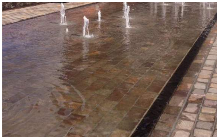
Waterafvoer met roostergoten rond bedriegertjes, Zwart gietijzeren rooster, Sleufrooster NW100, SW 16/120, C250 Goot type BGZ S 100, DDC Regenwater afvoertechniek
