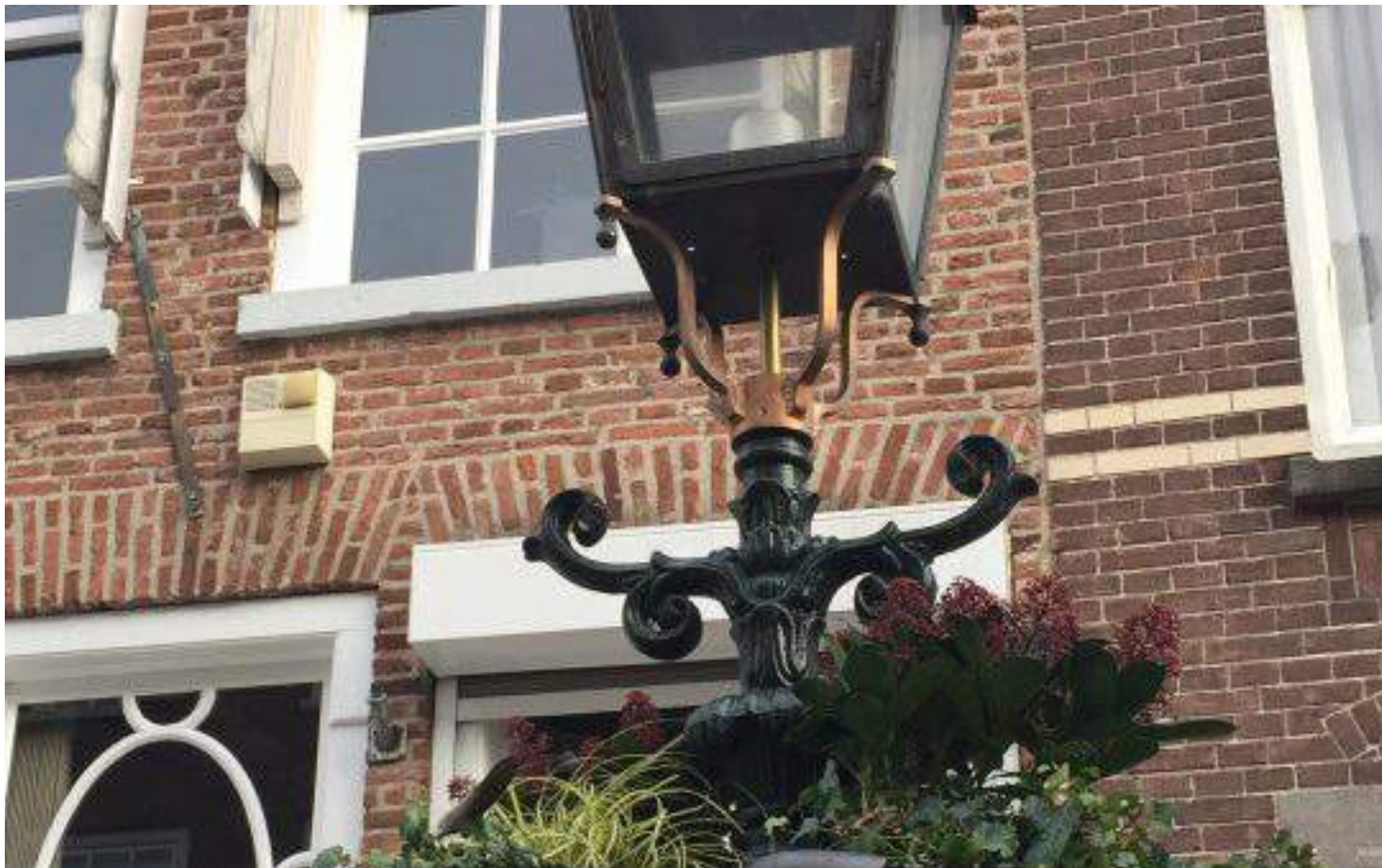
Voorbeeld klassieke lichtmast met LED armatuur
