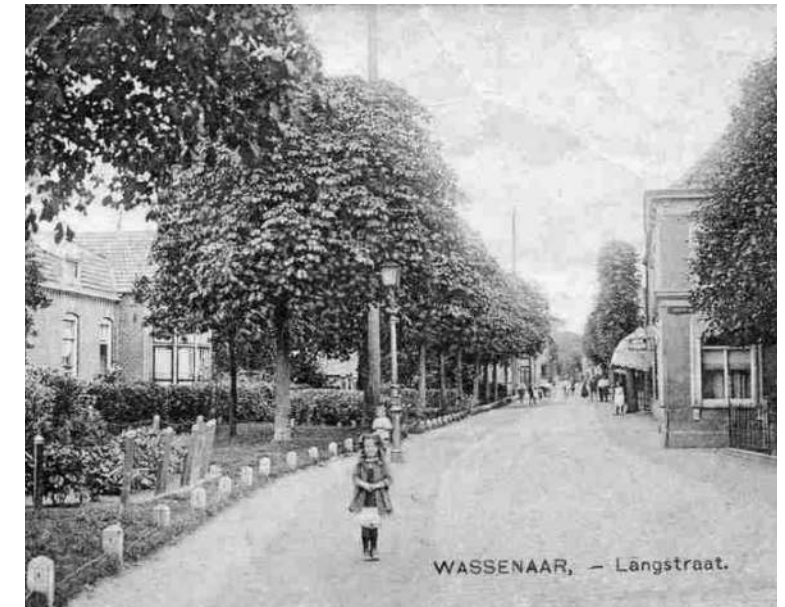
Langstraat, gezien vanaf de huidige rotonde
