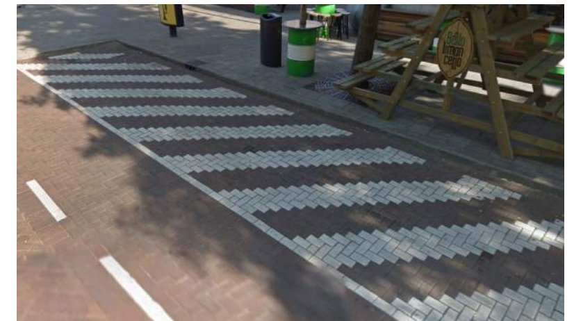
Voorbeeld markering voor laden en lossen. (Rotterdam, Schilderstraat) Elleboogverband, waalformaat. (afwijkend van de foto) Witte steen: Gebakken klinkers DF 'Geglazuurd wit'. Wienerberger.
