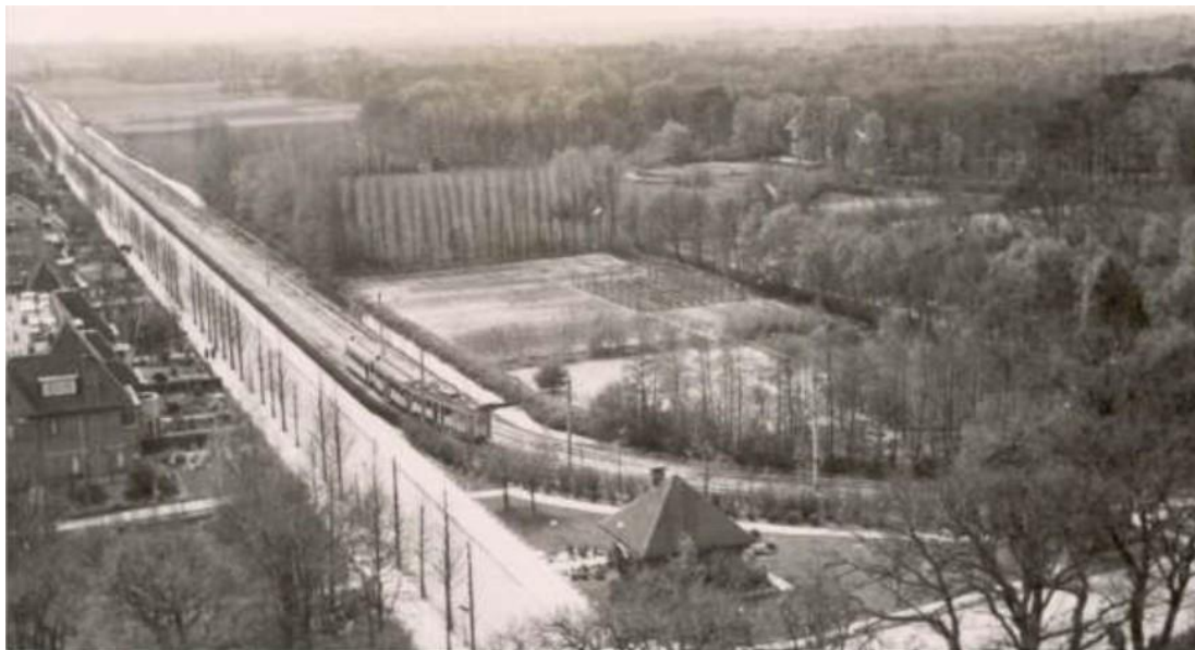
Situatie in 1941: zicht op plangebied vanaf de toren van de Goede Herderkerk. Links de Wittenburgerweg, met de trambaan in een bocht over Stoephout (Bron: Buitenplaats Klein Stoephout, Tuinhistorisch onderzoek en waardstelling)
