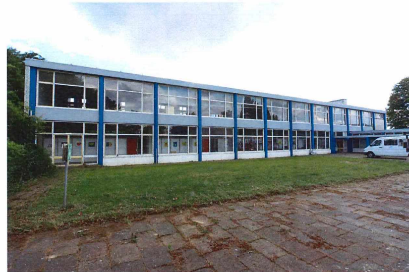
Overzicht pleingevel hoofdgebouw
