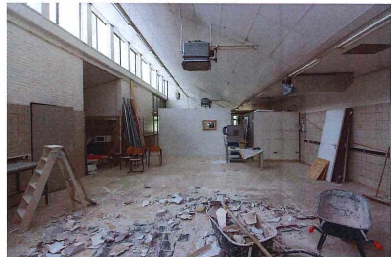
Bouwlokaal met links verschillende nevenruimten
