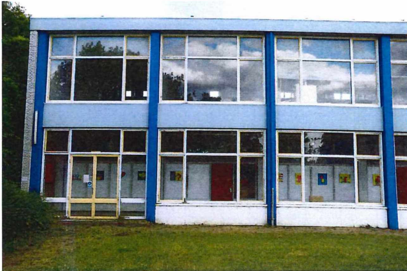
Detail voorgevel hoofdgebouw pleinzijde
