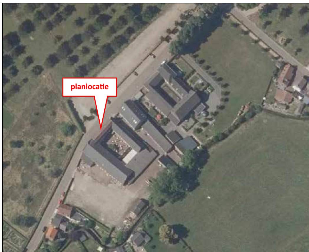
Figuur 1. Luchtfoto met ligging bedrijfslocatie
