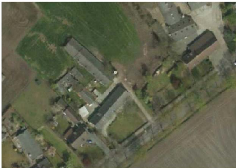
Figuur: bestaande situatie Lochterweg 26
