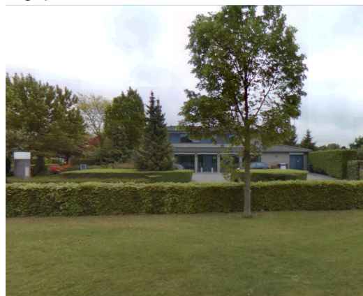
Bedrijfspan met parkeerplaatsen
