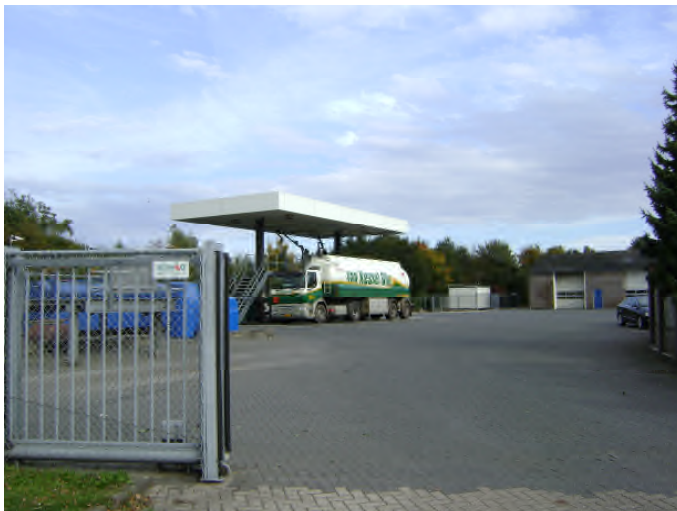
Figuur 2 Open toegangshek tot terrein
