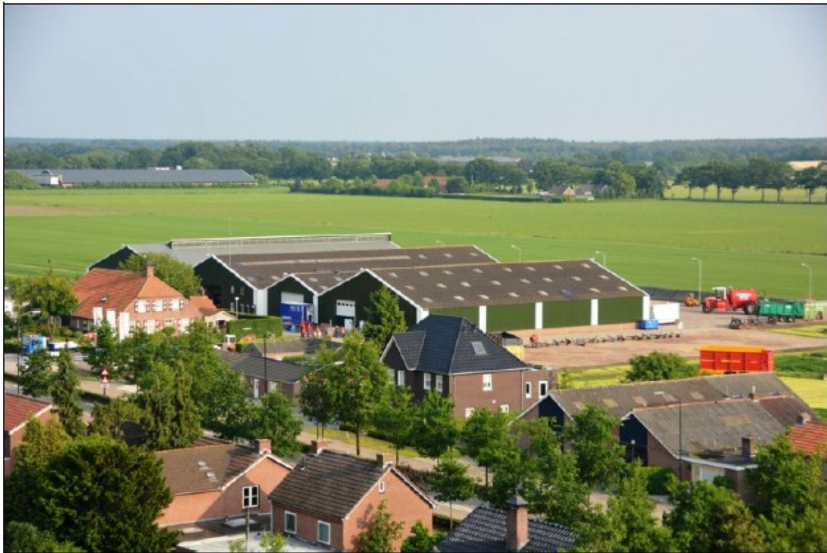
Figuur 3 Zicht op de locatie
