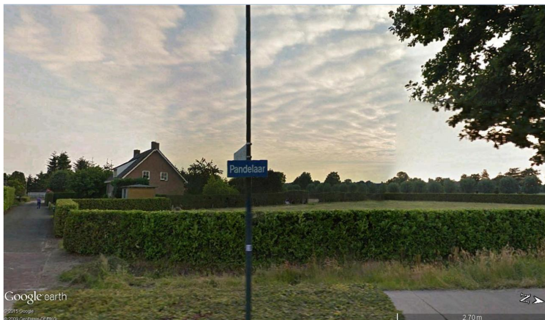
Afbeelding 3 Streetview bestaande situatie
