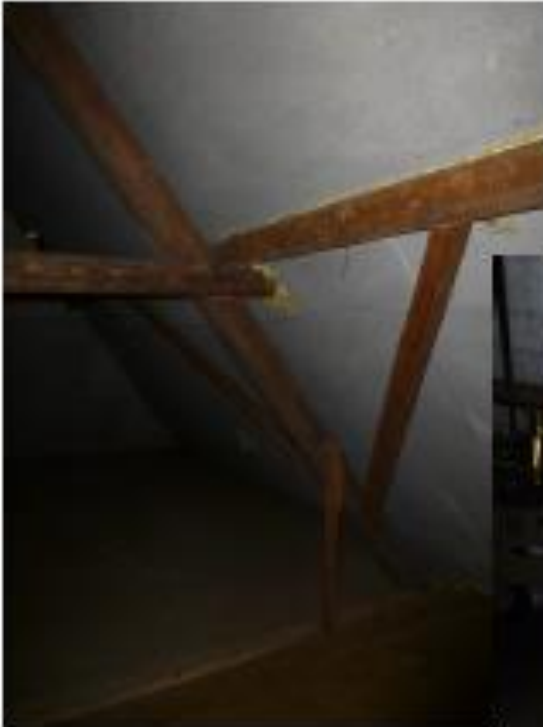
Nieuw en deels fake(?) spantwerk in de kap van het staldeel en woondeel.
