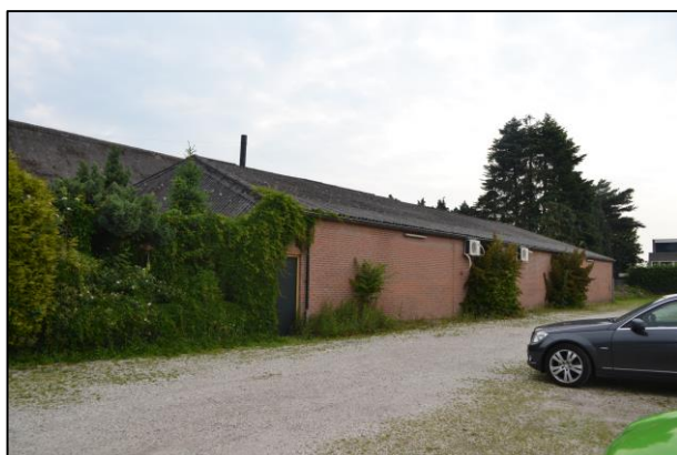
Foto 3. Te slopen schuur (zuidzijde) aan grindpad
