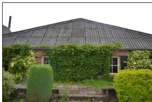
Foto 2. Voorzijde te slopen schuur
