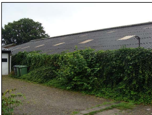
Foto 1. Te slopen stal
