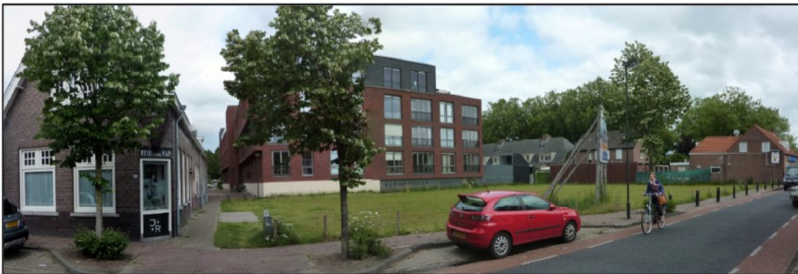
Huidige inrichting van het plangebied, gezien vanaf het Kruseind. Het plangebied betreft de braakliggende gronden. Bron: De Loods architecten en adviseurs bv, 2016.
