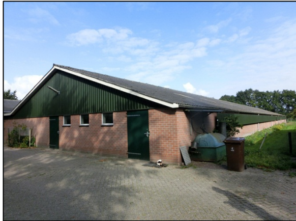
Voorgevel en rechter zijgevel
