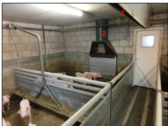
Detailfoto van de luchtinlaat via open strook in het plafond (1) en luchtuitlaat via koker met meetventilator en smoorklep (2) naar centrale luchtkanaal
