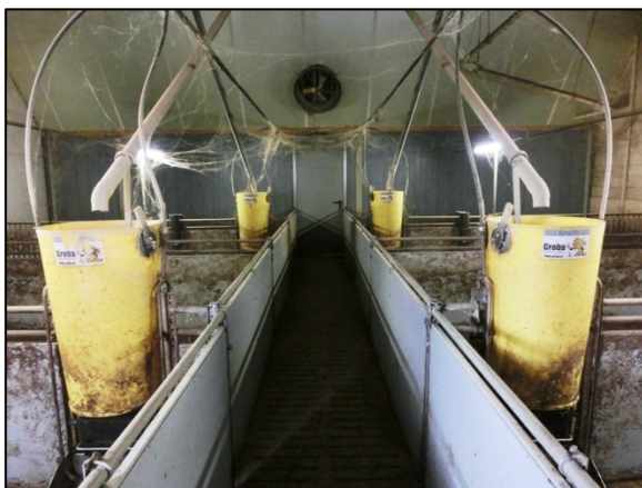
Overzichtsfoto van een afdeling met acht hokken, met de luchtinlaat via betonroostervloer van de voergang en de luchtuitlaat via de koker met meetventilator en smoorkleppen boven de deur, naar het centrale luchtkanaal
