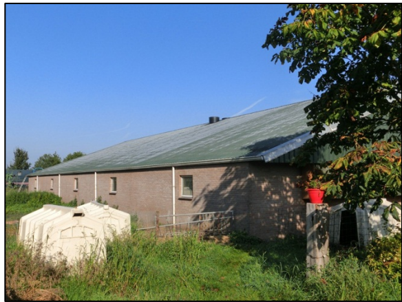
Linker zijgevel met 5 ramen (één in elke afdeling) en ventilatorkokers centraal in de nok van de stal
