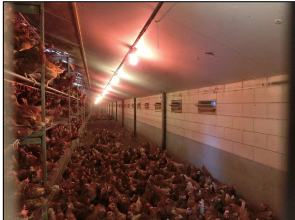
Zijgevel met inlaatventielen, plafond met PL-lampen, strooiselvloer en volièrestelling
