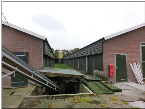
Zijgevel met inlaatventielen onder winddrukcap
