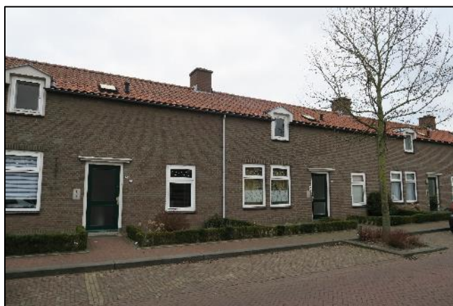
Foto 12. Woningen aan de Alde Biezenstraat (52 t/m 62)
