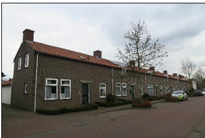
Foto 11. Woningen aan de Alde Biezenstraat (52 t/m 62)
