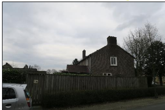
Foto 2. Westgevel Nieuwe uitleg 32
