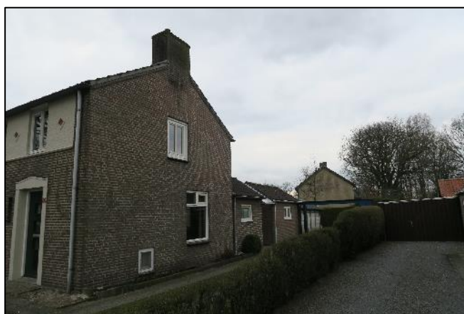
Foto 3. Oostgevel Nieuwe uitleg 26
