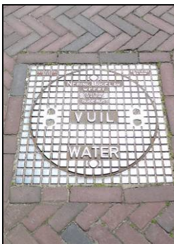
Referentie: Vuil- en schoon regenwater gescheiden
