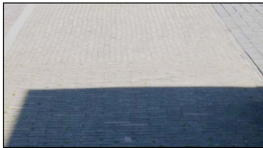
Referentie: Bermen en voetpaden in betonnen waalformaten
