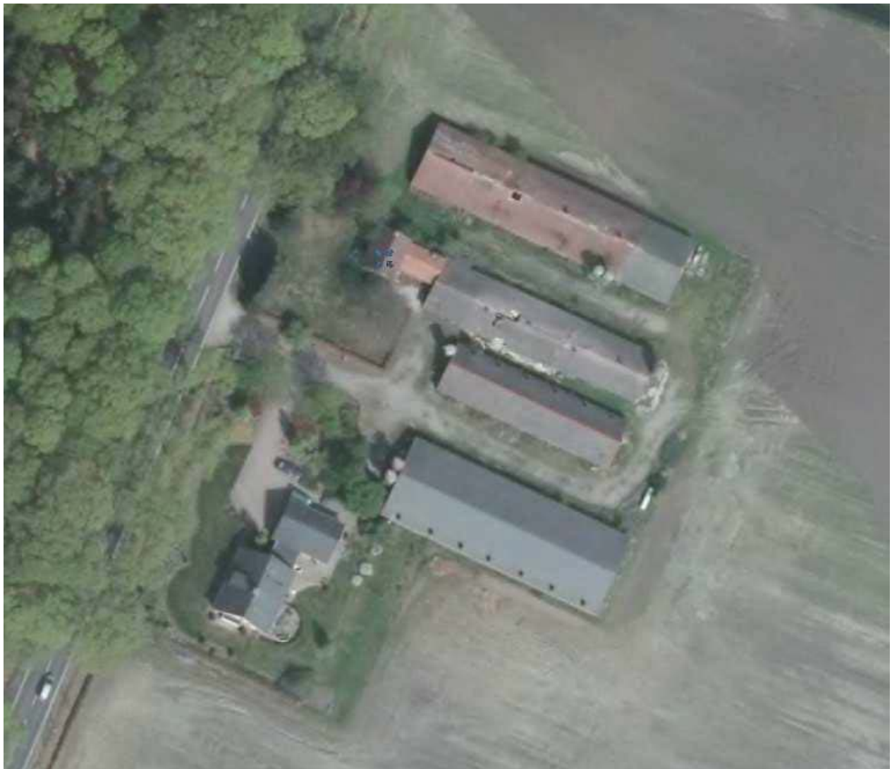
Foto: situatie Kruisberglaan 17, voor sloop bedrijfsgebouwen
