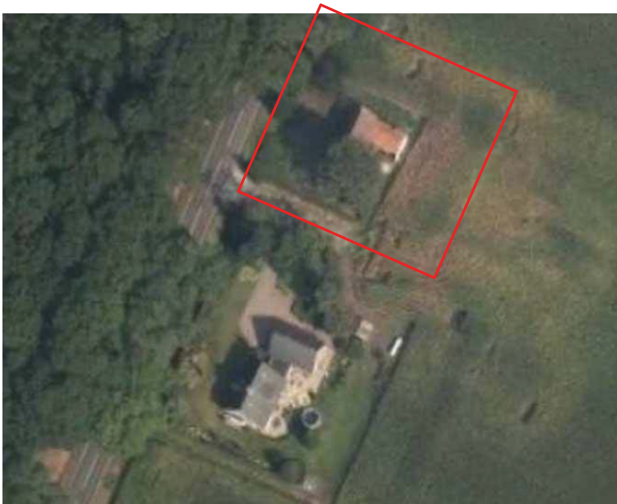
figuur: luchtfoto bestaande situatie, na sloop bedrijfsgebouwen. Rood omkaderd de oorspronkelijke bedrijfswoning.
