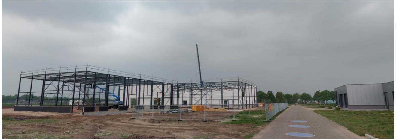
(foto; bouw bedrijfspanden Smartpark Gemert)
