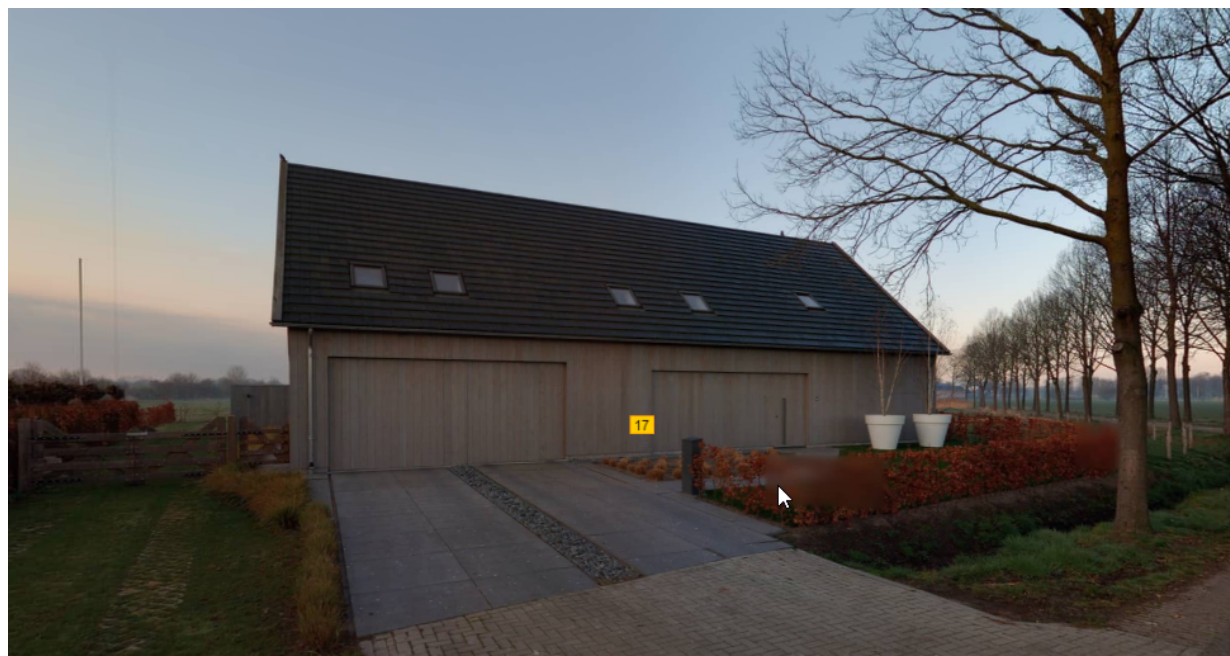
Woning Broekstraat 17 Gemert gebouwd met RvR bouwtitel gemeente
