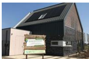
Cradle to Cradle geïnspireerde woning in Someren Gemeente Someren zet flinke stap in duurzaamheid in woonwijk Groote Hoeven. Met een statiegeldregeling wordt gestimuleerd om circulair te bouwen. Met de circulaire voorbeeldwoning voegt de gemeente zelf daad bij het woord. Deze woning is door 2.0 Architecten ontworpen en bevat vele C2C gecertificeerde materialen. Mail naar demo-woning@someren.nl voor een afspraak of bel (0493) 494 888.
