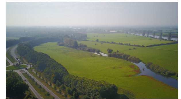
De rondweg bij Gennep (1977) heeft een breed profiel en fungeert als ruimtelijke, recreatieve en ecologische barrière
