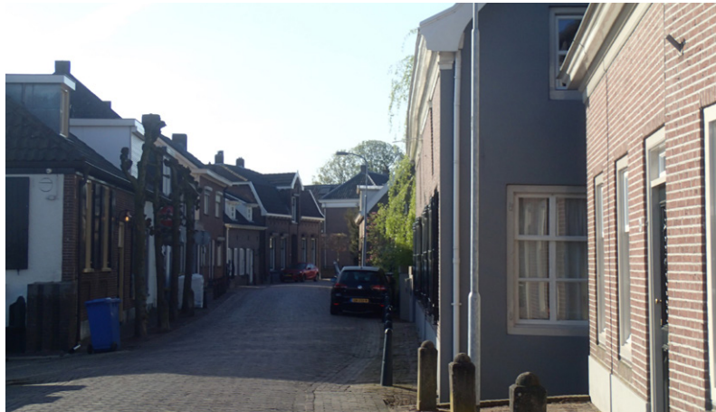
Bijzonder en kwetsbaar dijktraject Kerkdriel. Aan twee zijden van de dijk staan karakteristieke historische panden.
