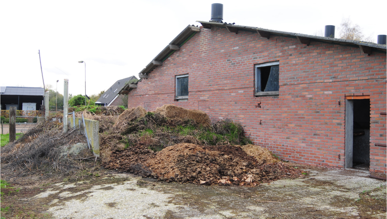
Afbeelding 7. Achtererf met op de achtergrond een woning gelegen aan de Gagelkampweg 1
