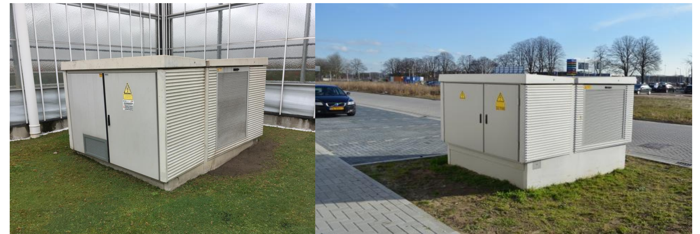
Diabolo compact station 2000 kVA, ~2,5 x 3 x 2,1 meter, En 150 - 630 kVA; 2 x 1,8 x 1,60 meter
