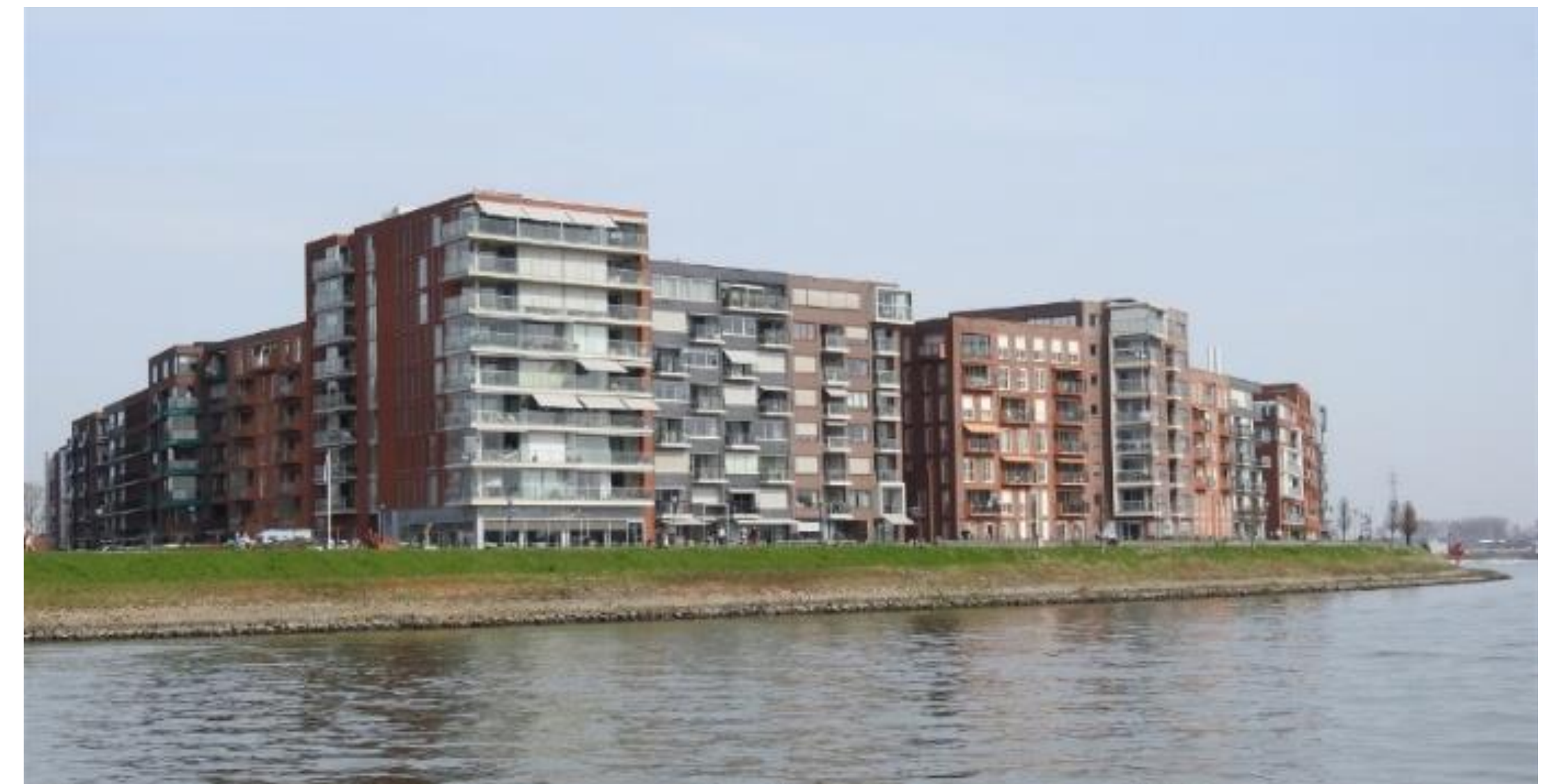
Figuur: TEO project Merwehoofd, Papendrecht. Gerealiseerd in 2003. Omvang 401 appartementen. Zie ook https://www.aquathermie.nl/praktijk/aquathermie+projectenkaart/1639284.aspx?t=TEO-Merwehoofd-Papendrecht
