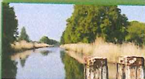
1. Bodemsanering Apeldoorns Kanaal
