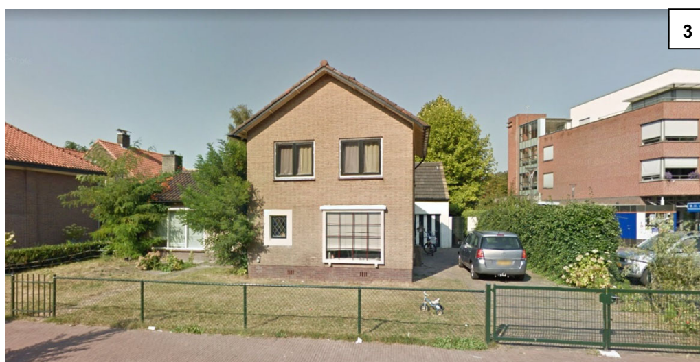
Impressies huidige situatie plangebied met referentie naar luchtfoto (bron: SAB).
