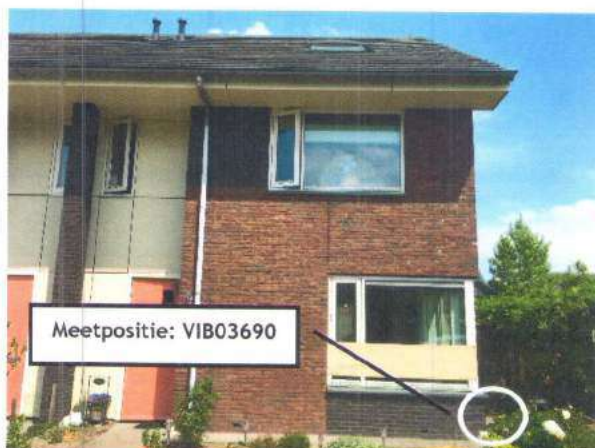
Afb. II: Meetpositie conform SBR- A: Schade aan gebouwen | Voorgevel- Gooilandlaan 51 te Heerenveen
