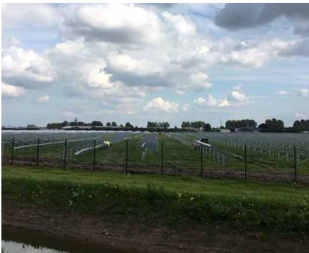
Afbeelding 19. Referentiebeeld hekwerk (tijdens de aanleg van het zonnepark) (Groene Hoek, Haarlemmermeer)
