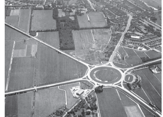
De rotonde als knooppunt tussen de rijkswegen A32 en A7 in 1963. Tussen de A32 en Schans zijn de Hepkema-bosjes en de sportvelden zichtbaar. [Oud-Heerenveen vanuit de lucht]
