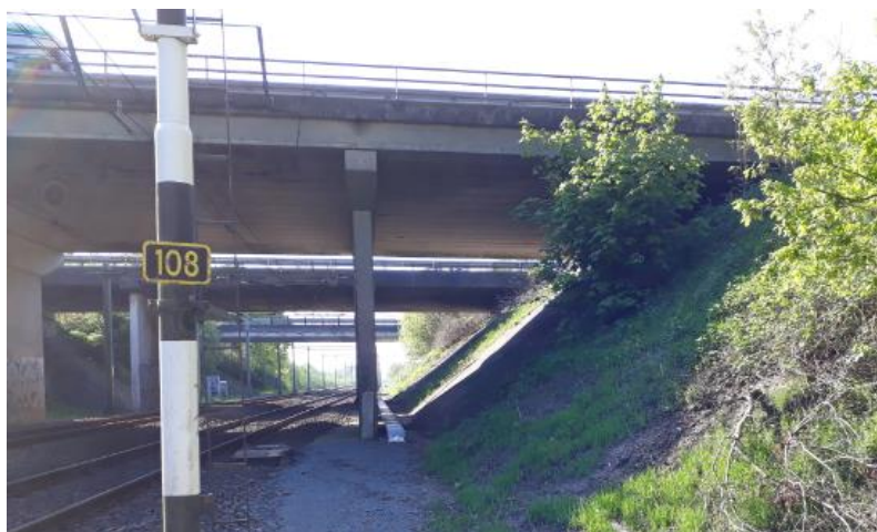
Figuur 5 viaducten A7 (viaduct 1 en 2), vanuit het noorden gezien
