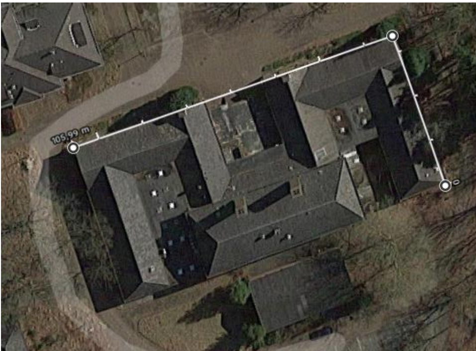
Figuur 11. Opmeting via google Earth.
