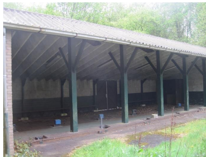
Figuur 90. Kapschuur schietbaan.
