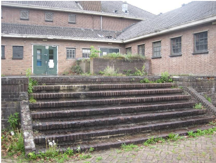
Figuur 49. Voorzijde Keukengebouw met trap.
