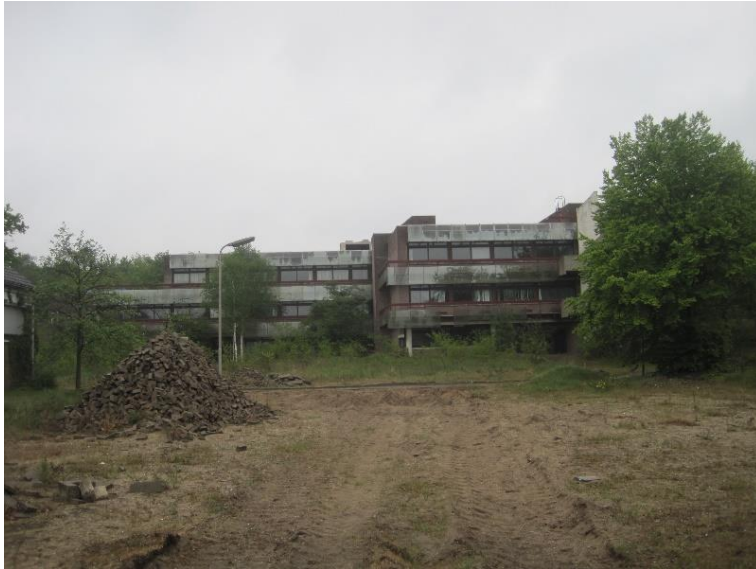
Figuur 60. Gebouw Spiegelhorst voorkant.
