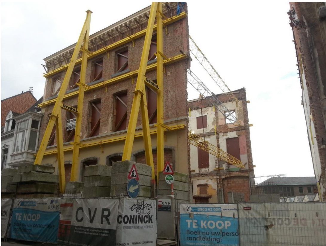
Figuur 13. Voorbeeld behoud van waardevolle gevels te Gent (verschijningsvorm) met daarachter een nieuwe 'vrij' indeelbare invulling.
