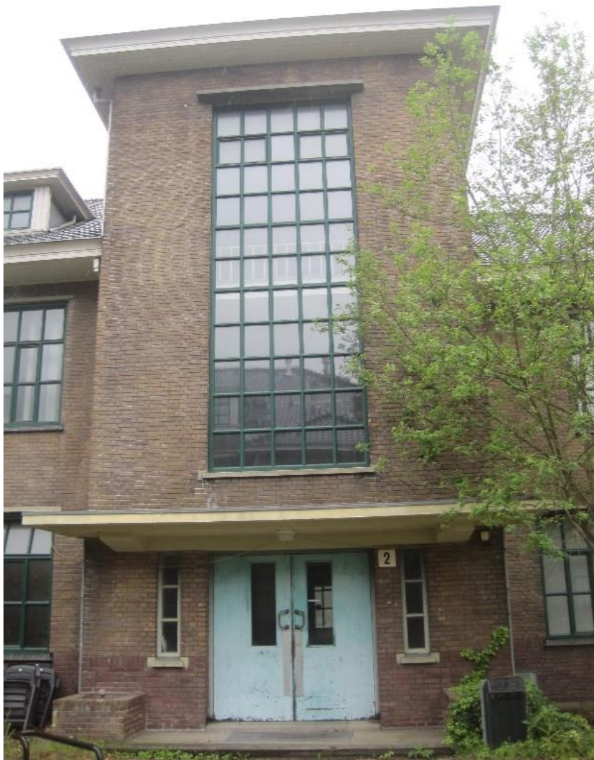
Figuur 45. Voorportaal gebouw 2.
