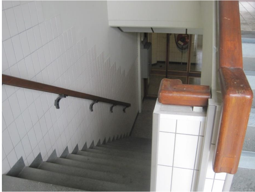
Figuur 48. Gedeelte leuning en tegels trappenhuis gebouw 2.
