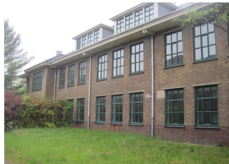
Figuur 43. Achterzijde gebouw 2.
