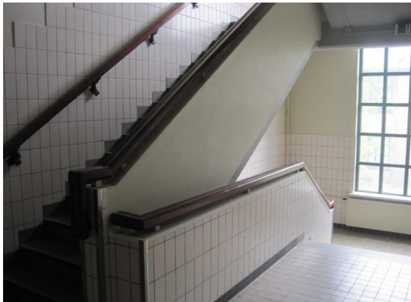
Figuur 46. Trappenhuis gebouw 2.
