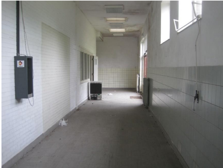
Figuur 56. Gang op begane grond Keukengebouw.
