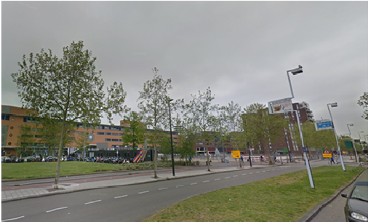
Figuur 14 Zicht op het Stationsgebouw met grasveld (bron: Google maps)
