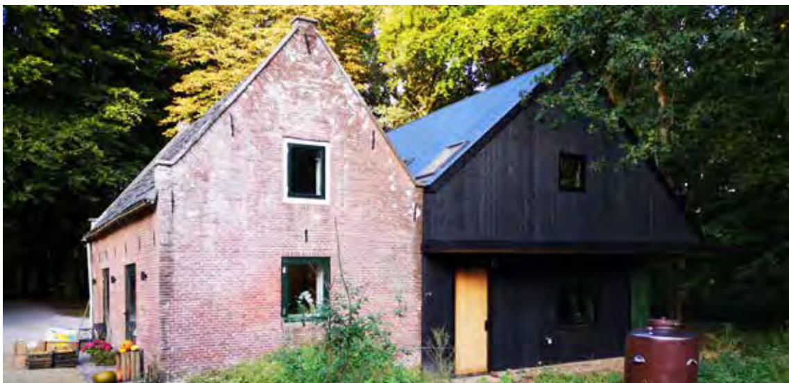
nieuwbouw aan monument geschakeld | dubbele woning | Schoots architecten
