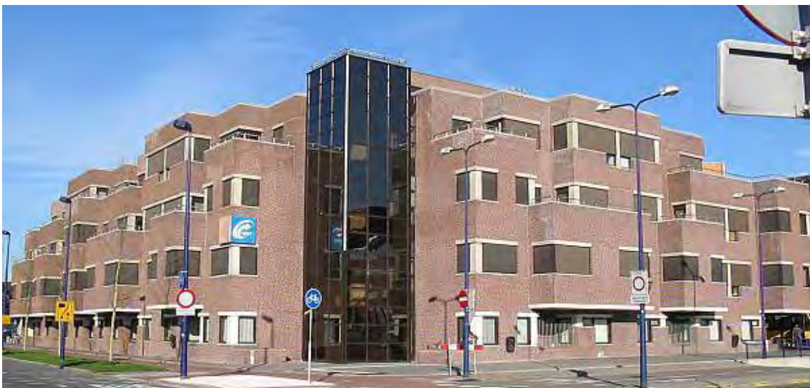
GAK kantoor Stationsplein | negatief advies op aanvraag monumentenstatus | inmiddels gesloopt
