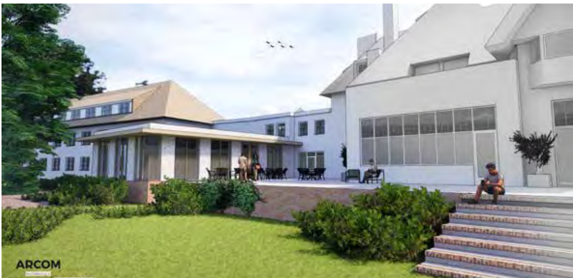
ARCOM villa Monnikenberg | vh klooster De Stad Gods | restauratie en nieuwbouw | ARCOM architectuur
