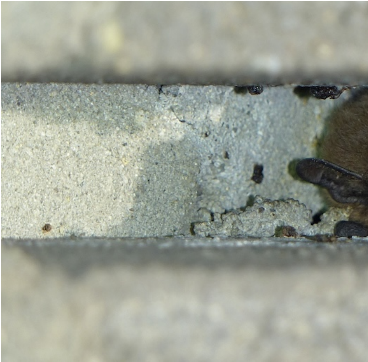
Beeld: Dwergvleermuis in een open voeg in metselwerk Erik Korsten
