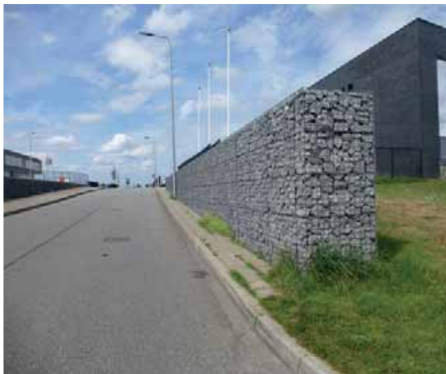
Schanskorven begeleiden het hoogteverschil van de steilrand
