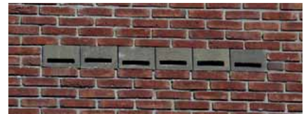
nestkasten geïntegreerd in de gevel
