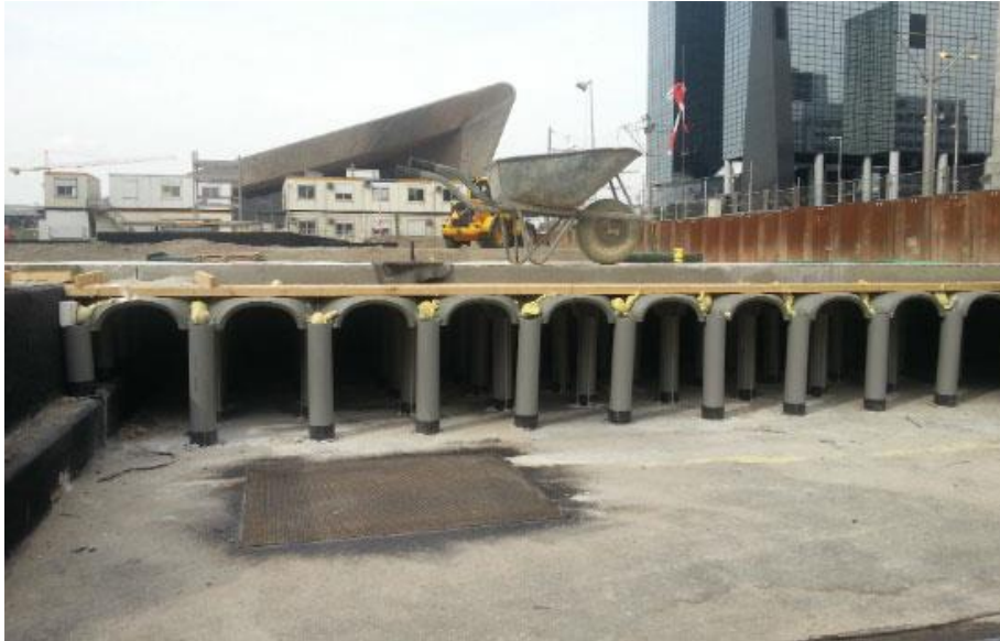
Afbeelding 4.13 Watershells op parkeergarage voor Centraal Station Rotterdam
