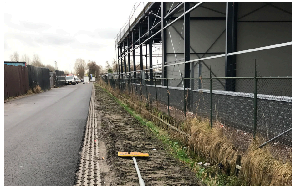
Zone 1: Bedrijven in aanbouw ten zuiden van Bosland
