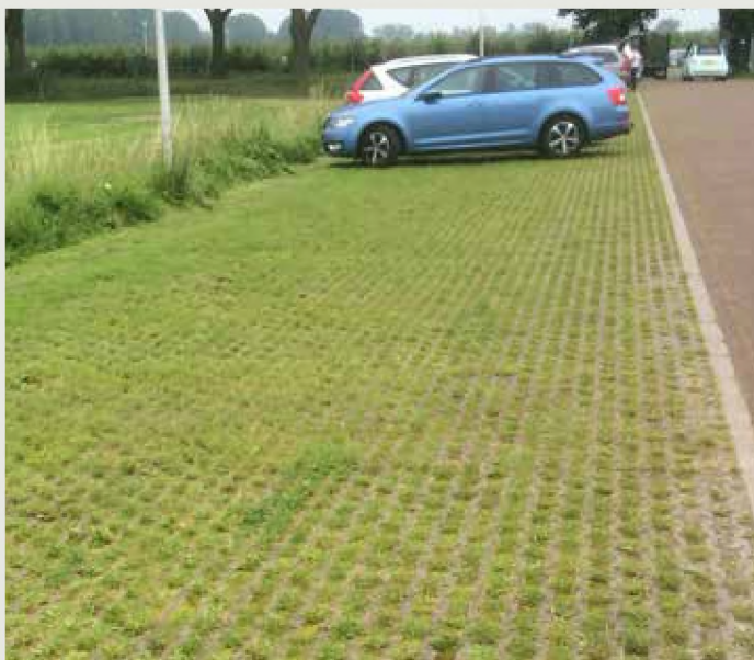
Referentie hergebruik grasverharding
