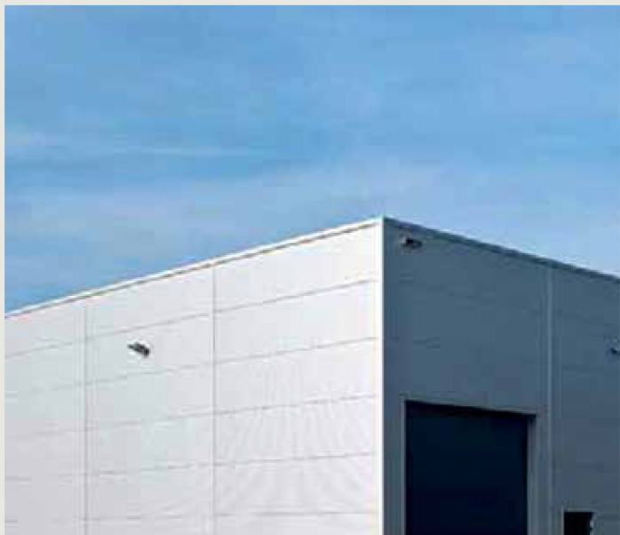
Aansluiting in kleur bij de omliggende kasbeouwing
