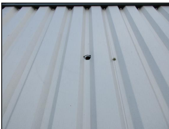
Foto 5: Metalen golfplaten van loodsen
