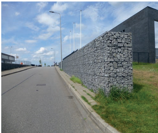
Schanskorven begeleiden het hoogteverschil van de steilrand
