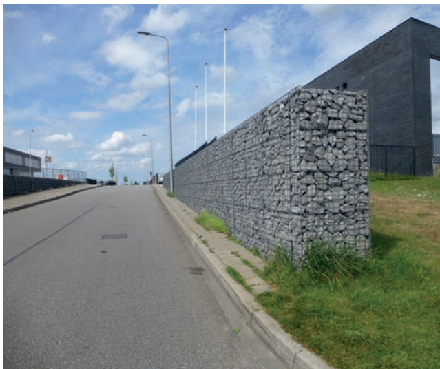
Schanskorven begeleiden het hoogteverschil van de steilrand
