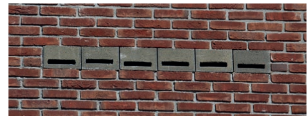
nestkasten geïntegreerd in de gevel
