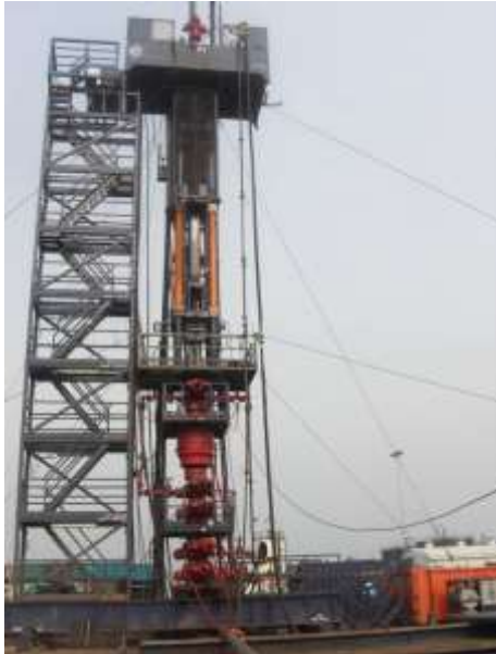
Figuur 6.8 | Een onderhoudsoperatie met een HWU
