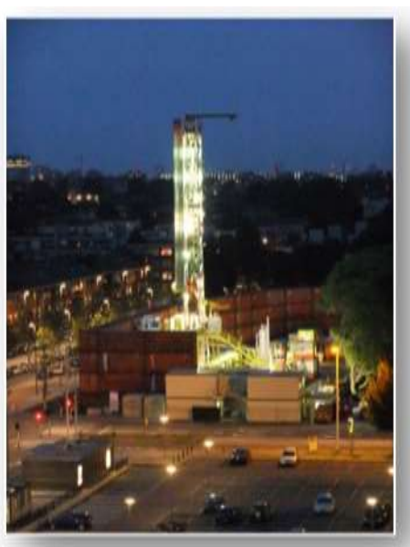
Figuur 6.5 | Voorbeeld Booropstelling geothermie (Den Haag Zuidwest)
