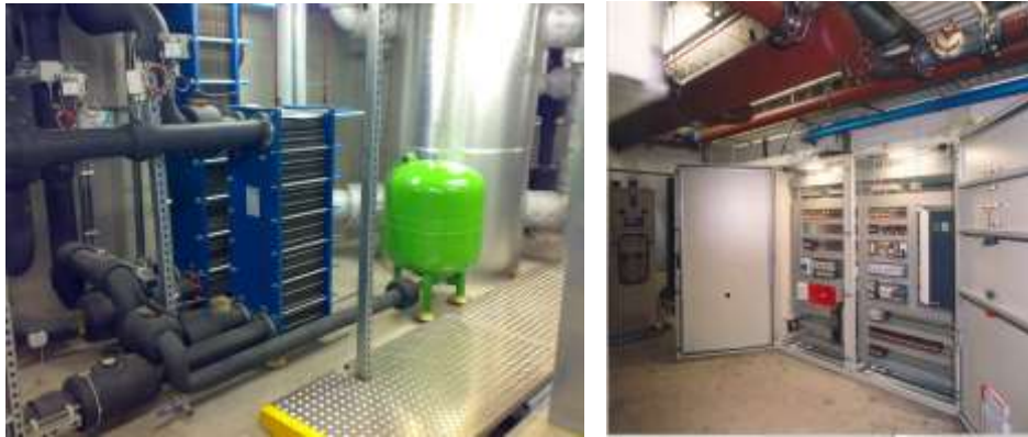
Figuur 6.2 | Voorbeeld warmtewisselaars en regelkast
