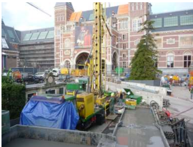
Figuur 6.1 | Voorbeeld booropstelling
