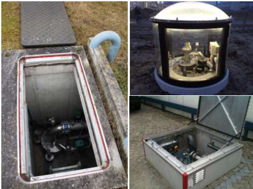
Figuur 6.3 | Voorbeelden afwerking putbehuizingen
