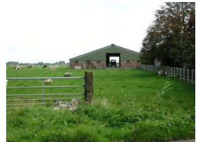
Een horizontale geleding in de kopgevel
