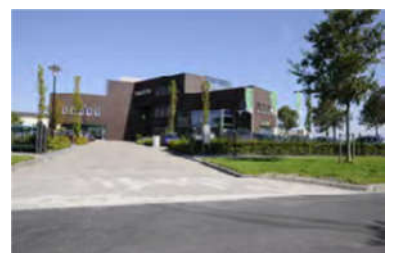
Recente bouw met een representatieve architectuur
