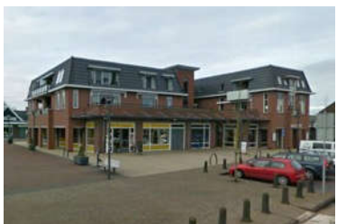
Winkelcentrum de Boogert: variatie in kaphoogte en structuur onderdeel van het centrumlinten gebied
