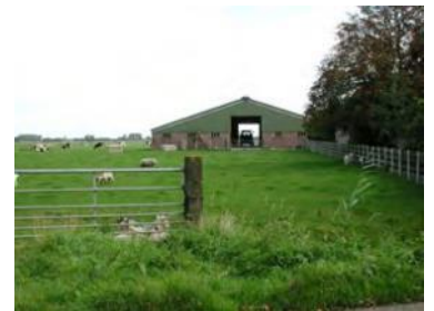
Een horizontale geleding in de kopgevel
