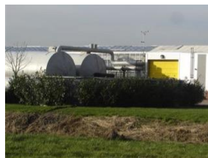
De silo verscholen achter beplanting
