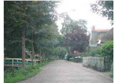
Een asymmetrisch profiel met dicht op de straat staande bebouwing en bruggen
