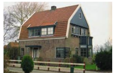
Gebouwen bestaan uit een onderbouw van één tot twee lagen met variërende kappen en bij voorkeur een lage goothoogte
