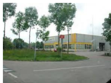
Eenvoudige bedrijfsbebouwing midden in het bedrijfsgebied
