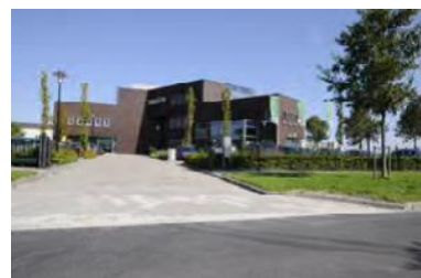
Recente bouw met een representatieve architectuur
