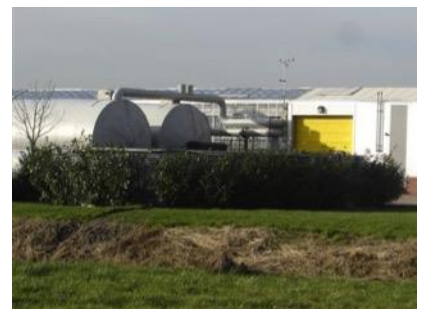
De silo verscholen achter beplanting
