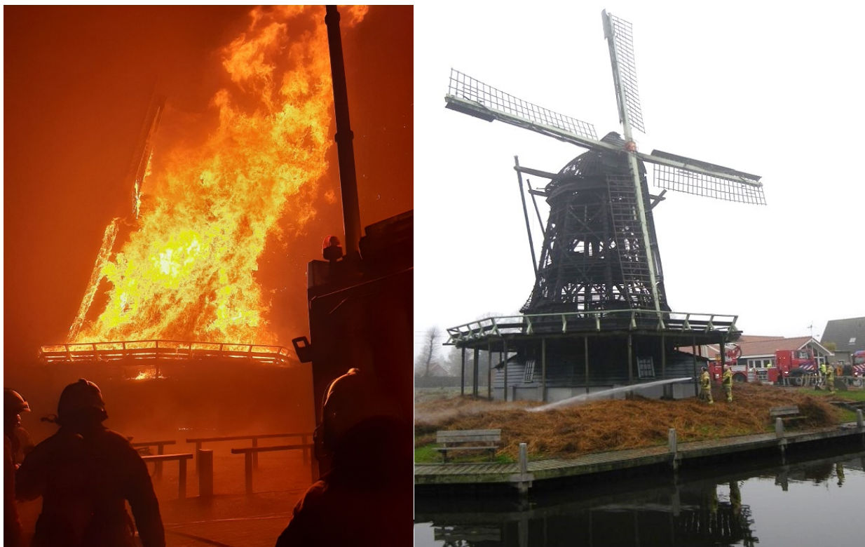
De brandweer zette in op behoud van het geraamte van de molen. Dat is gelukt.
