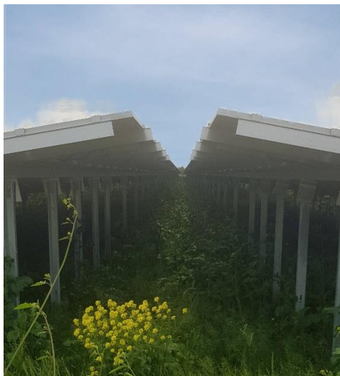
Figuur 1 Foto van een opstelling met ruimte in de 'nok' van de opstelling. Dit zorgt voor voldoende licht en water op de bodem.
