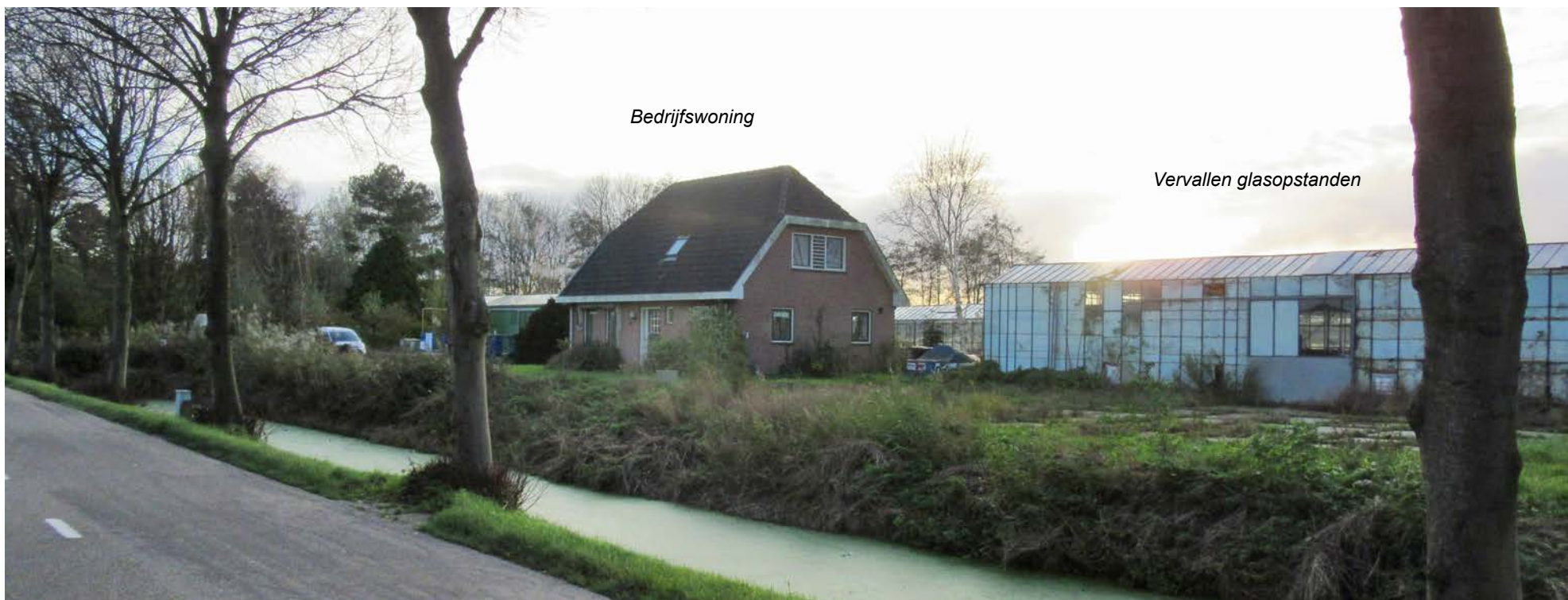
Aanzicht vanaf de Ganker, bedrijfswoning en vervallen glasopstanden
