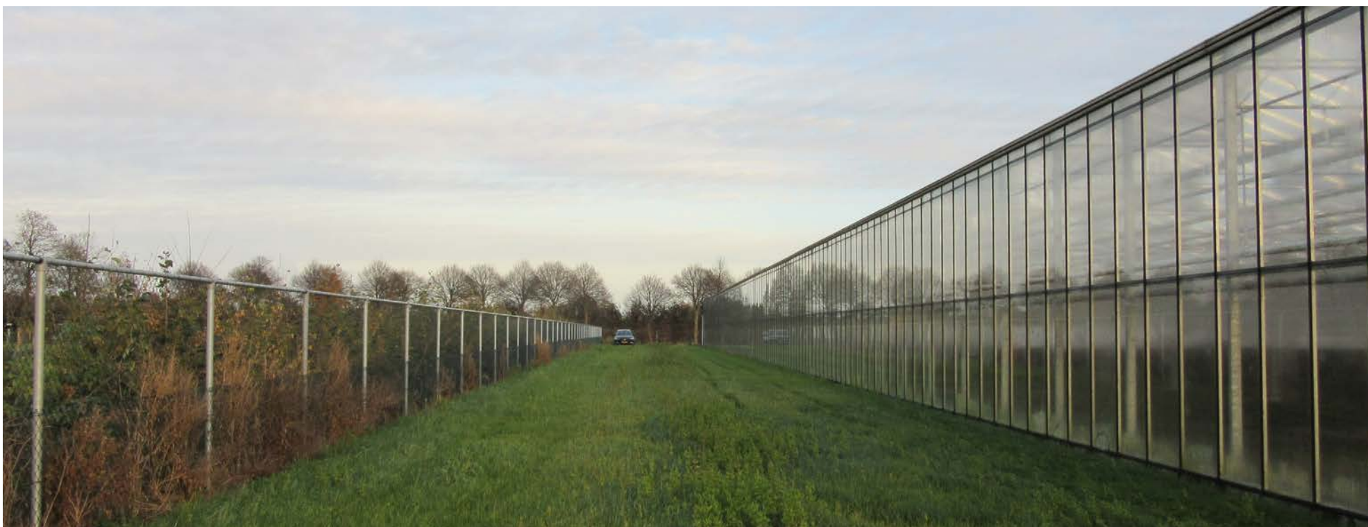
Noordelijke grens perceel, begrenzing met hekwerk
